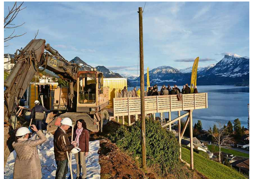
Neue Wohnungen in Ennetbürgen: Am Montag erfolgte der Spatenstich.
