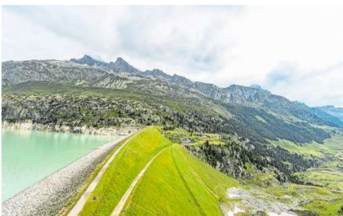
Der Staudamm auf der Göschenalp.
